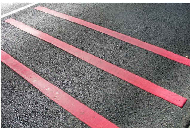
Akustyczne czerwone linie – dzięki odpowiedniej grubości masy termoplastycznej powodują efekt akustyczny i wibrowanie na kierownicy. Jest to czytelny sygnał dla kierowcy, że powinien zwolnić i zachować szczególną ostrożność.
