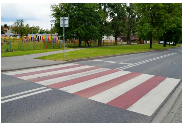
Znak P-10 – przejście dla pieszych z dodatkowymi pasami w kolorze czerwonym. Zwiększony kontrast powoduje lepszą widoczność samego przejścia, ale przede wszystkim pieszych znajdujących się na nim.
