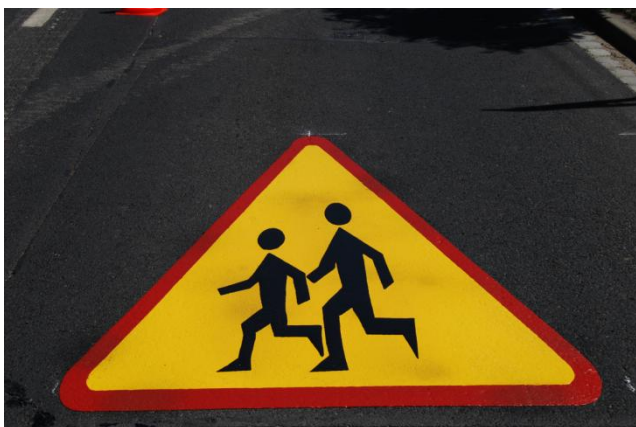
Znak A-17 („uwaga dzieci”) zastosowany na jezdni jako wzmocnienie znaku pionowego. Odblaskowy, dobrze widoczny przed świtem, po zmroku oraz przy opadach atmosferycznych.
