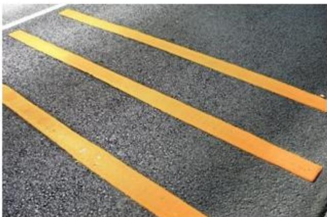
Желтые полосы торможения – благодаря соответствующей толщине термопластической массы вызывают акустический эффект и лёгкую вибрацию руля. Это является прямым сигналом для водителя, что он должен сбросить скорость и сохранять особую осторожность на дороге.
